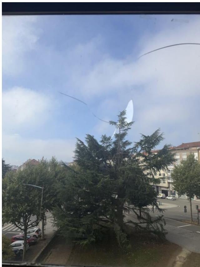
Foto 1 – Vista xeral da fiestra, coa fisura ramificada ben visible sobre o fondo do ceo.
